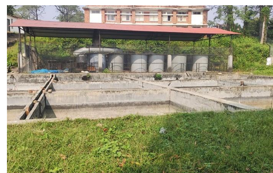
Fig: Site Tank
